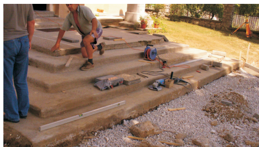
Pred renováciou schodiska
